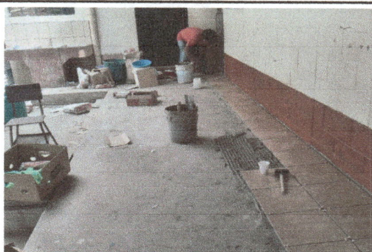
Foto 2: Instalción de piso cerámico del pasillo de las dos aulas
