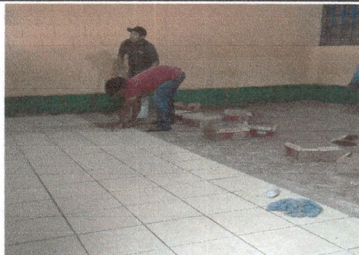
Foto1: Durante la Instalación de piso cerámico en las aulas.
