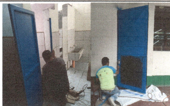
Foto 4: Durante la instalación y pintada de las puertas de los sanitarios y aulas
