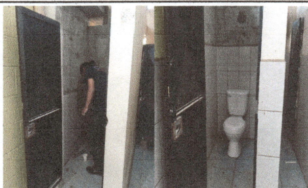
Foto 3: Instalación de piso cerámico, asulejo en los baños e insalacion e los inodoros
